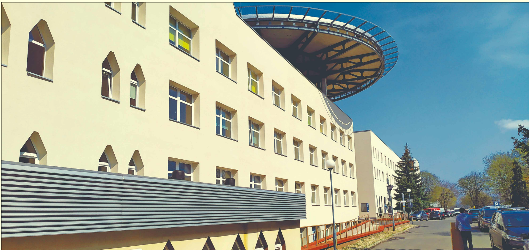
Szpital Uniwersytecki w Zielonej Górze po termomodernizacji
